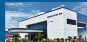
マレーシア工場
